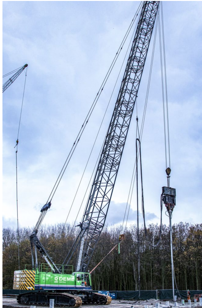
Figuur 3-9 Voorbeeld in te zetten heistelling
