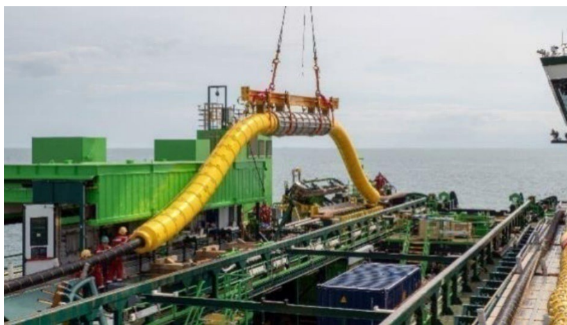
Figuur 3-25 Typische opstelling inline-verbindingsmof
