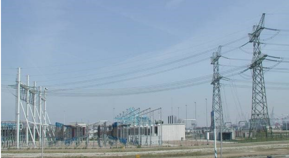
Afbeelding I.8 Afspanportaal
