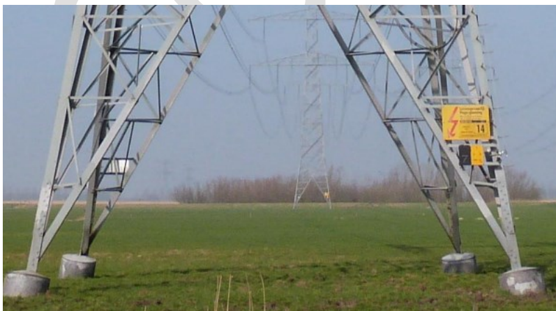
Afbeelding I.4 Fundering van een vakwerkmast
