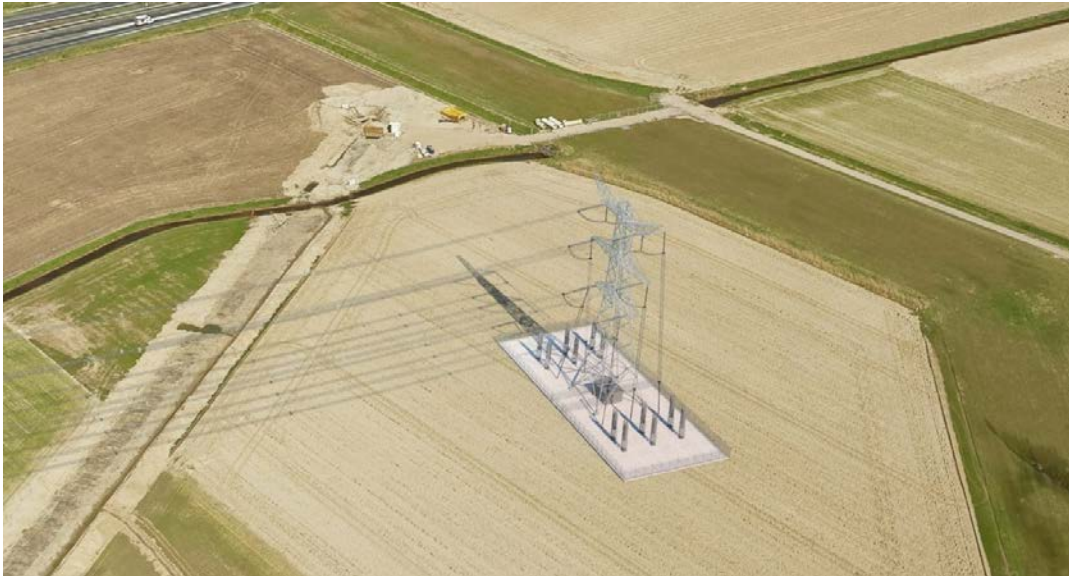
Afbeelding I.3 Opstijppunt 380 kV-verbinding (foto van de verbinding Rilland-Tilburg)
