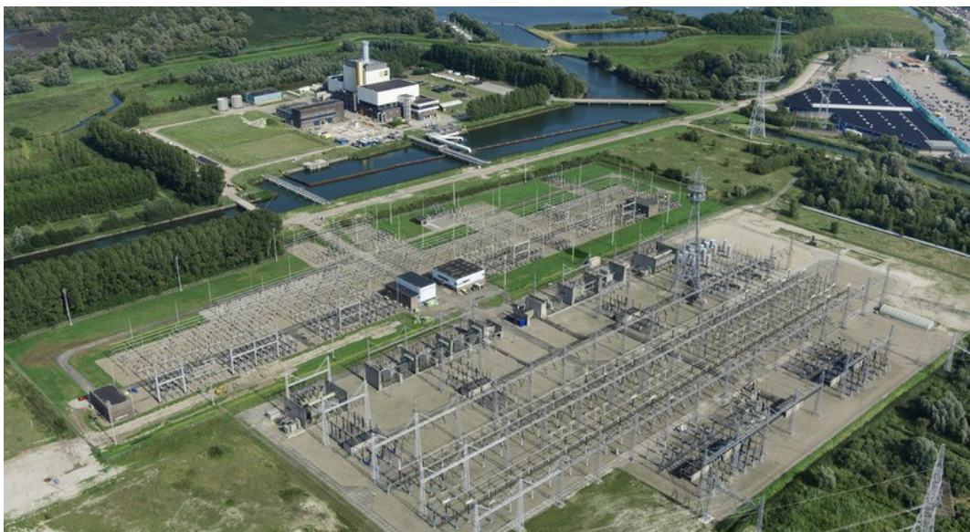
Afbeelding 1.2 380/150 kV-hoogspanningsstation in Diemen (bron: TenneT)
