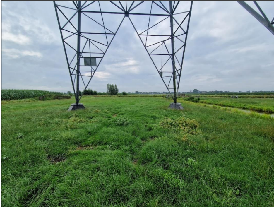
Figuur 3-5: Impressie van het perceel bij mast KIJ-DIM 041.
