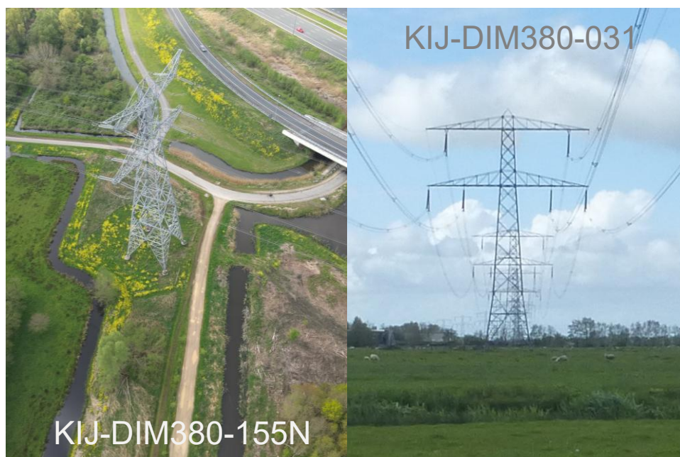
Figuur 5-5: Links de mastlocatie KIJ-DIM380 155N, waarbij voor boommarter potentieel geschikte bosstructuur in de directe omgeving aanwezig is (d.d. 22 april 2025), rechts de mastlocatie KIJ-DIM380 031, waarbij potentieel voor waterspitsmuis geschikte structuren aanwezig zijn bij de oeverzones (zie slootbegroeiing ten noorden van de mastlocatie, d.d. 10 juni 2024).
