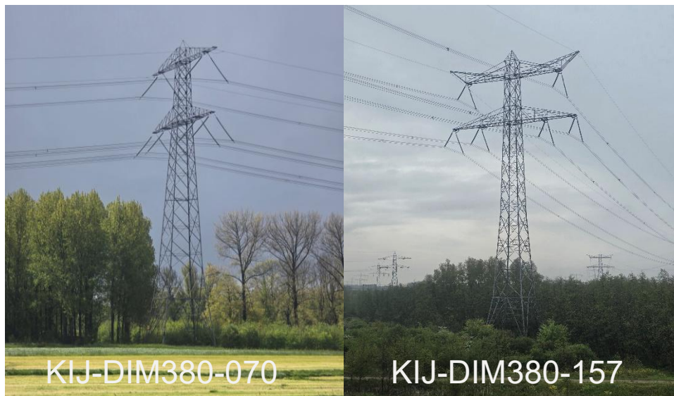
Figuur 5-2: Impressie van mastlocaties gelegen in extensief beheerde gras- en akkerlanden, nabij opgaande structuren, met links mastlocatie KIJ-DIM380 070 en rechts mastlocatie KIJ-DIM380 157.
