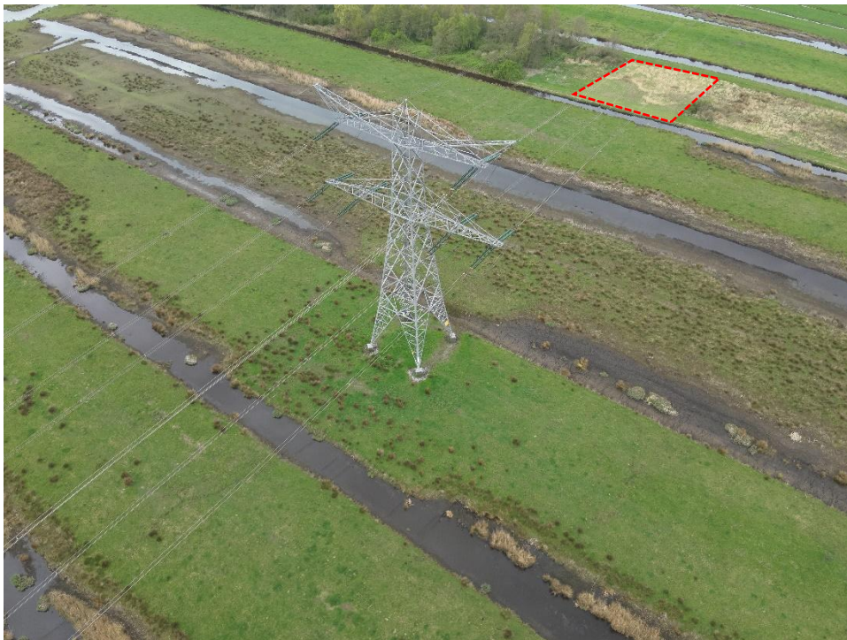
Figuur 7-5: De mastlocatie KIJ-DIM380 017, met aangegeven de beoogde lierlocatie in het NNN (rood omkaderd), te zien is dat het plaatselijk ontbreekt aan opgaande structuren, welke de kwalificerende waarden van het NNN-beheertype is (opname tijdens broedvogelinsectie, d.d. 15 april 2025).
