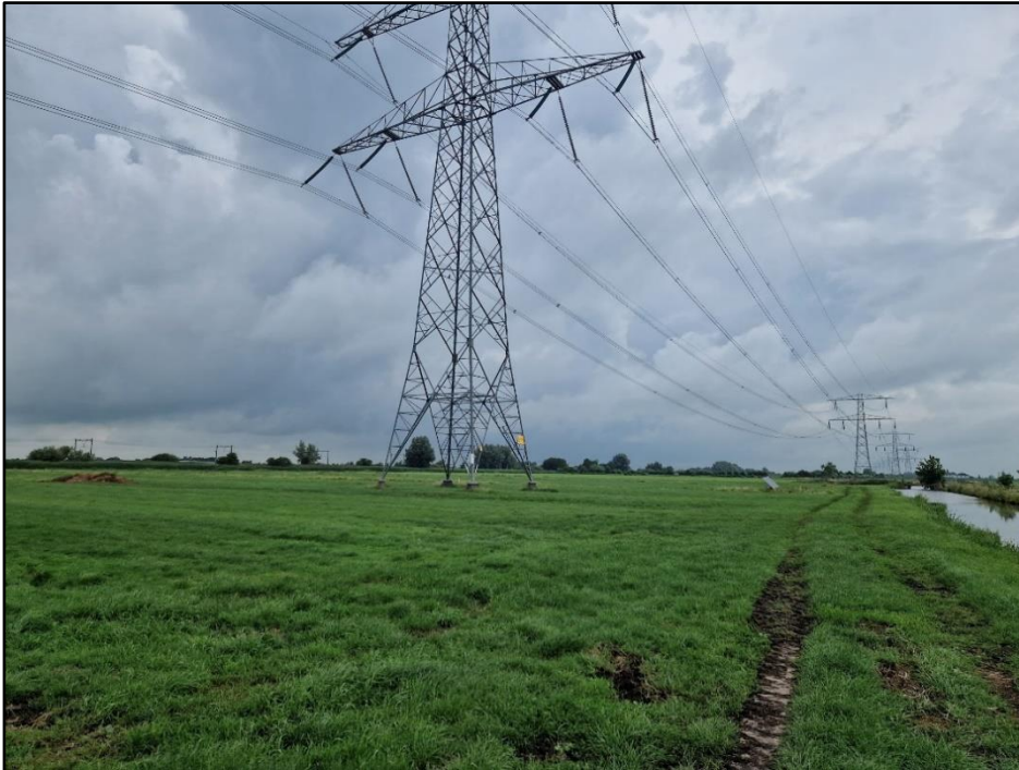
Figuur 3-8: Impressie van het perceel waar mast KIJ-DIM 044 op staat.
