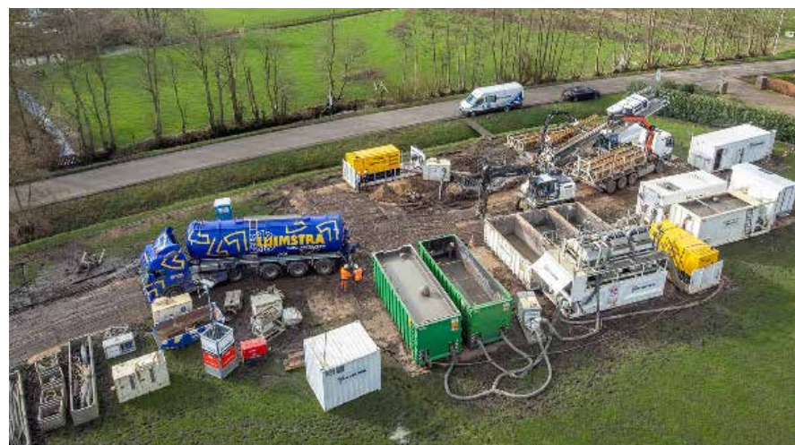
Afbeelding 22. Referentiebeeld van een gestuurde boring (TenneT)
