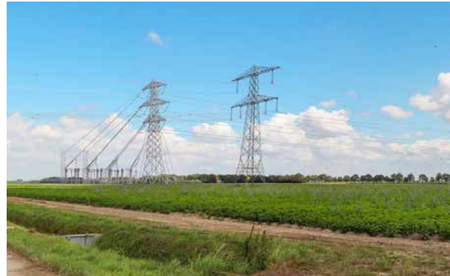
Afbeelding 73. Visualisatie van een 380 kV opstijgpunt
