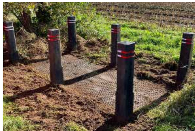
Afbeelding 72. Crossbondinglocatie (koppelplek) met aanrijbeveiliging (foto TenneT)
