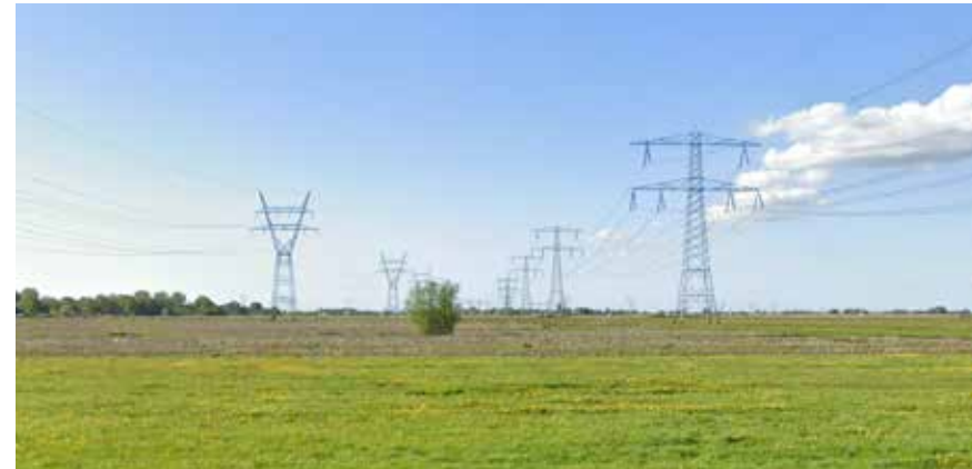
Afbeelding 59. Foto van een bestaande 380 kV donaumast (rechts) naast een bestaande 110 kV moldaumast bij Amsterdam. Bron: Google streetview
