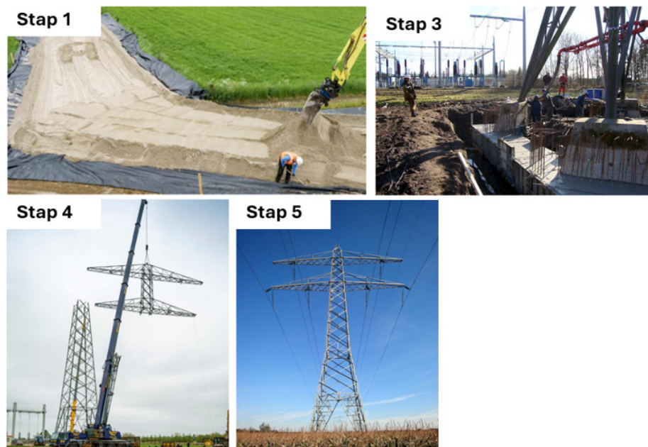
Afbeelding 5.2 Stappen werkzaamheden realisatie 380 kV-hoogspanningsmasten
