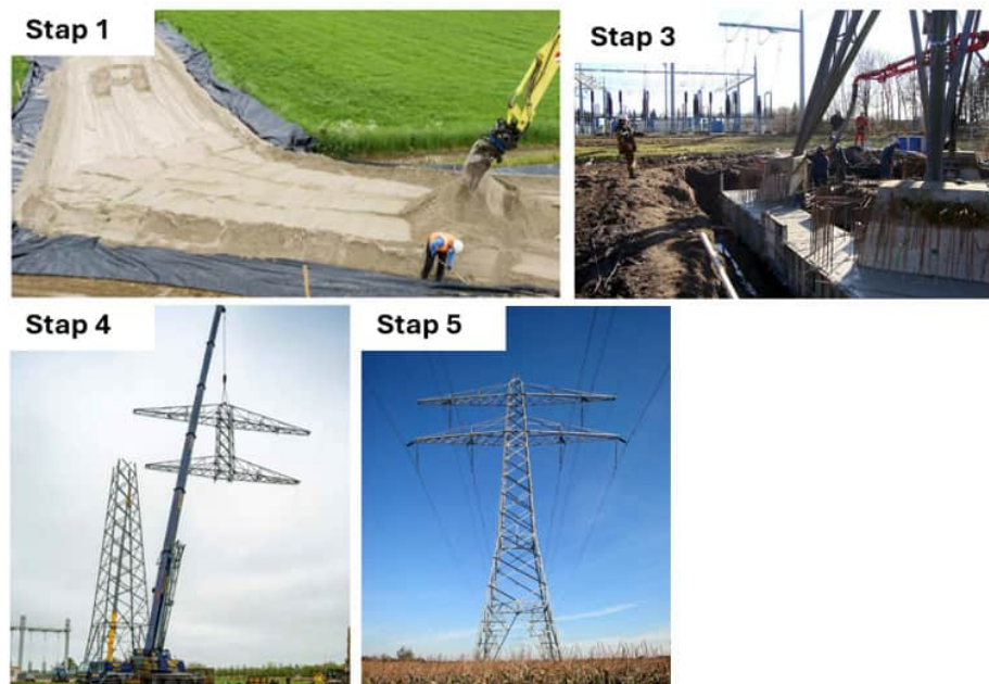
Afbeelding 5.2 Stappen werkzaamheden realisatie 380 kV-hoogspanningsmasten
