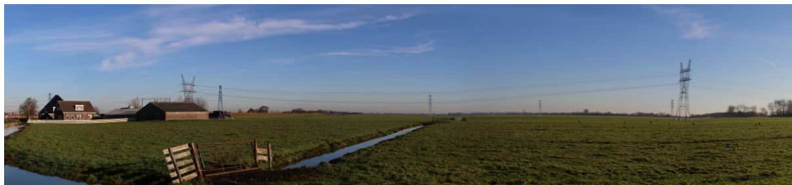
Afbeelding 5.18 Tracé RO-ZZ gezien in het oosten in het veenweidegebied van Broek op Waterland nabij Monnickendam, één mastenrij
