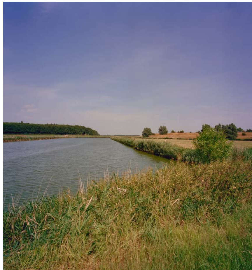
Afbeelding 3.16 Inundatiekanaal van de Pijp naar de inundatielsuis in de Sint Aagtendijk (Bron: Beeldbank RCE)
