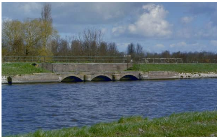
Afbeelding 3.17 Inlaatsluis nabij de Zuiddijk (Bron: Beeldbank RCE)
