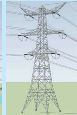
380kV hoekmast Moldau
