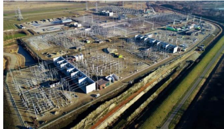
Afbeelding 5.4 380 kV-hoogspanningsstation Borssele tijdens de bouw
