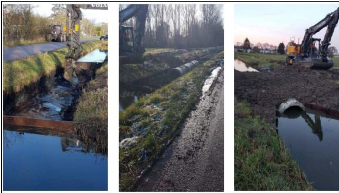
Figuur 4.8: Impressie afdammen, plaatsing duiker en afdichten. Deze foto's zijn ter illustratie.
