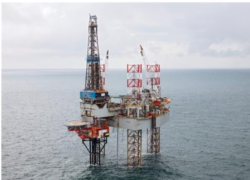
Figuur 5.3: Voorbeeld van een zelfheffend boorplatform (rechts) tijdens uitvoering van een boring bij een satellietplatform (links)
