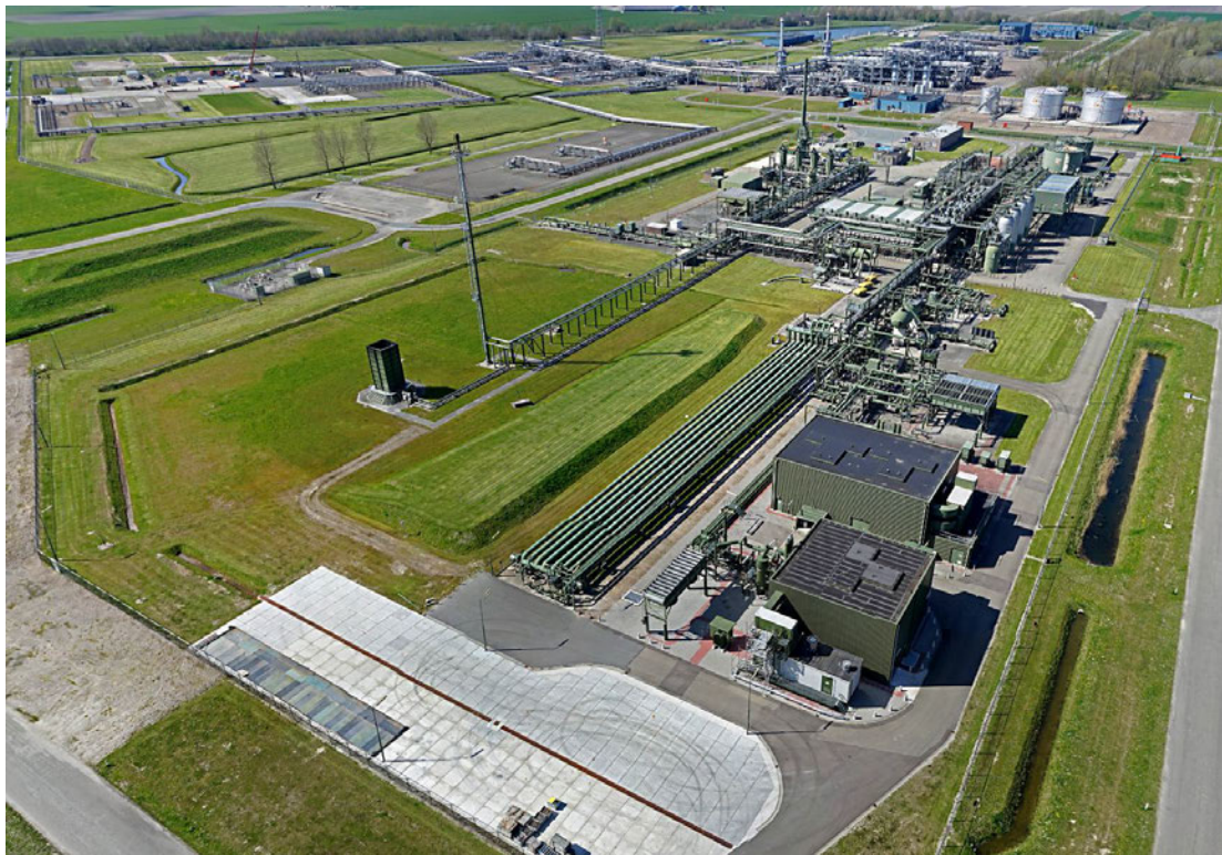
Figuur 3-4: Luchtfoto van de behandelingsinstallatie Grijpskerk GDF en Grijpskerk UGS in de achtergrond.
